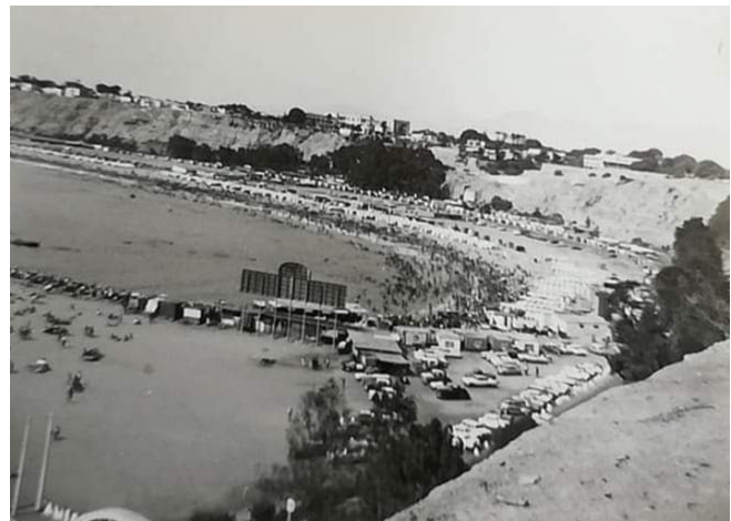
Fuente: Fuente: Pontificia Universidad Católica del Perú, 1967-Vista de Distrito Chorrillos
