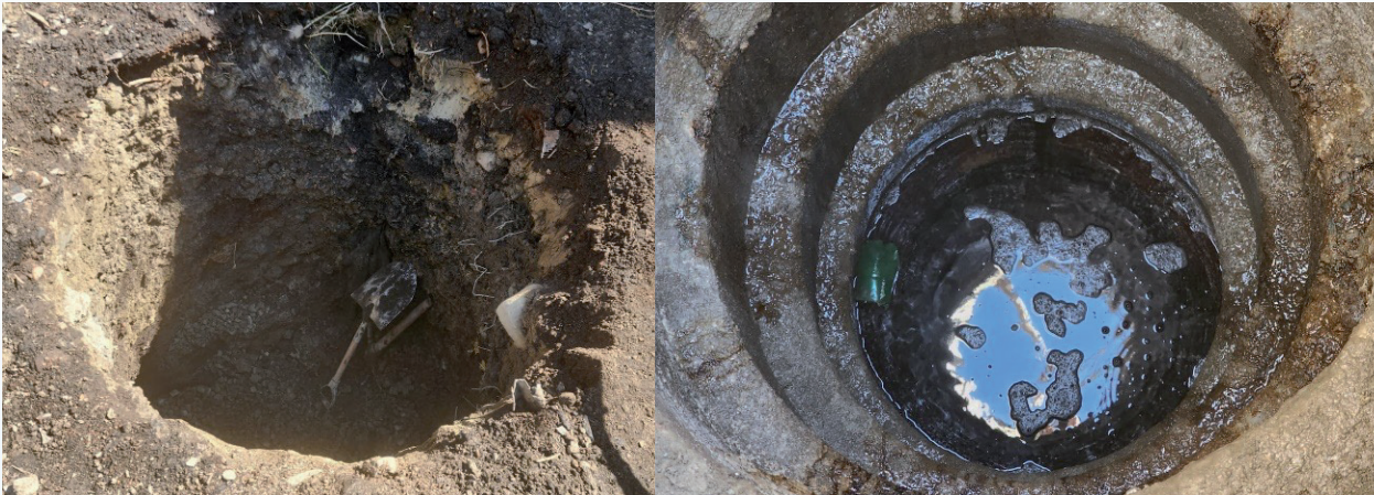
Figura N° 4. Presencia de material orgánico y agua residual durante la excavación de un pozo
