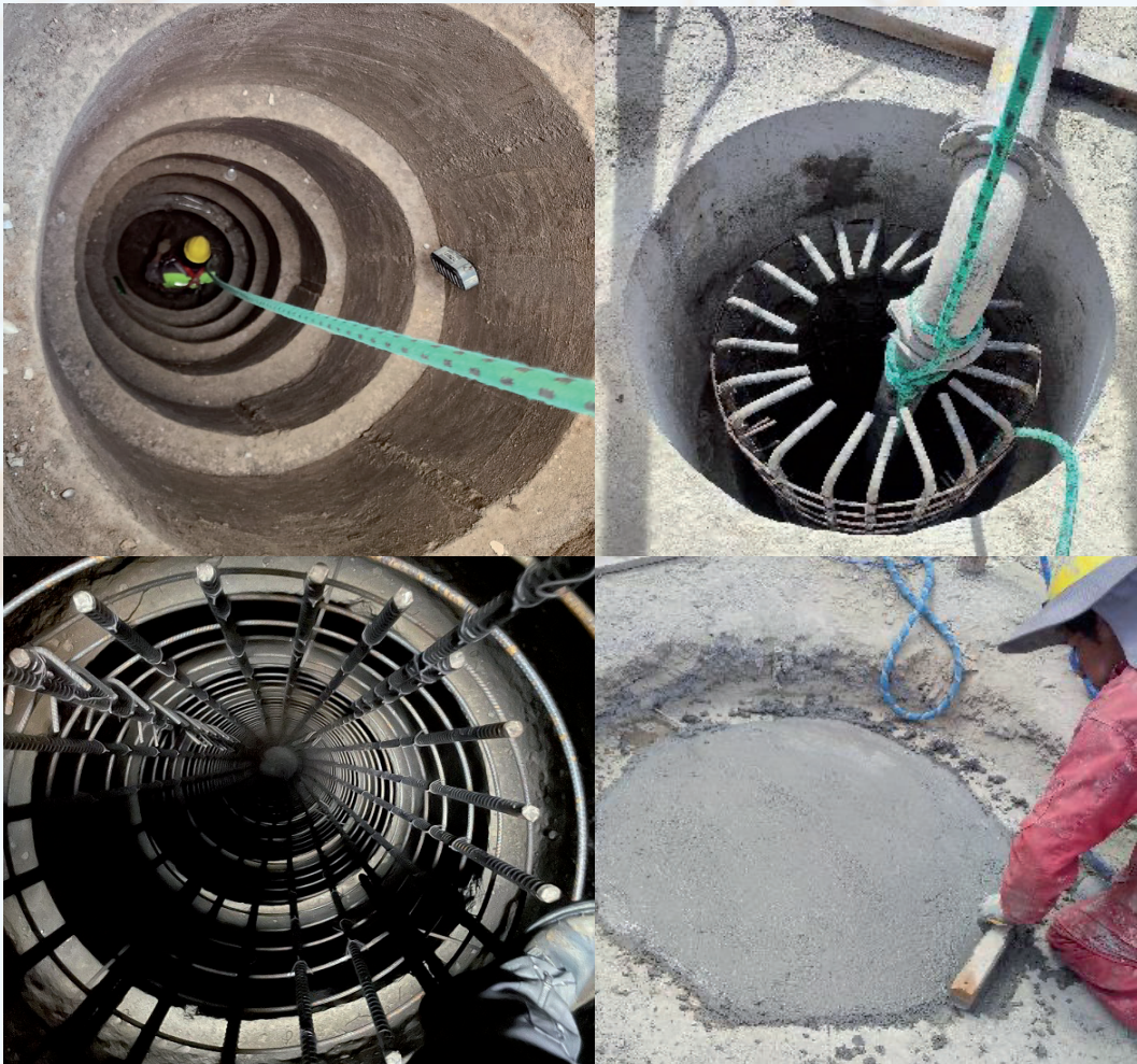
Figura N° 3. Izq arriba) Pozo con anillas concluidas; izq abajo) Colocado de armadura de pilote; Der arriba) Hormigonado de pilote; der abajo) Pilote concluido
