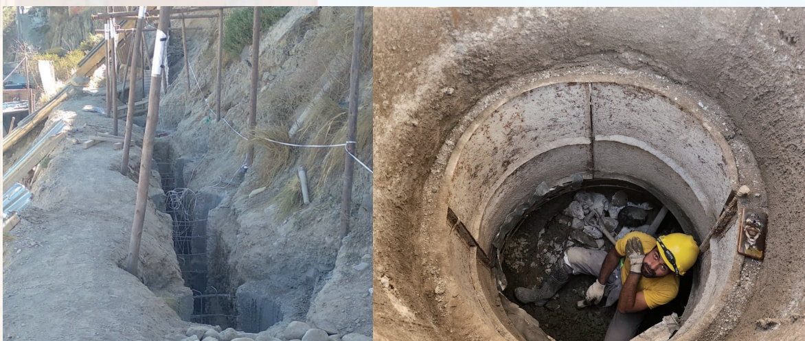
Figura N° 2. Proceso de excavación del pozo austríaco
