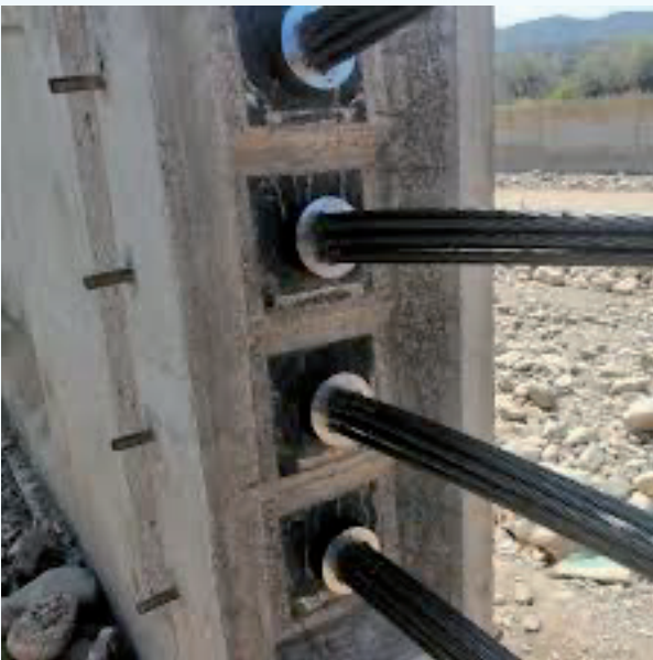
Colocado de viga sobre estribos – vista de anclajes y cables para postensado
