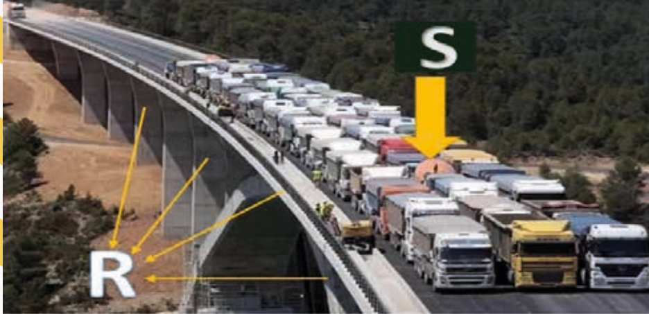
Figura 2 Solicitaciones y resistencia de un sistema estructural
