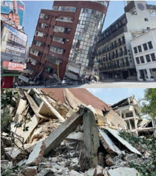
Figura 1. Edificios dañados y destruidos en Hualien – Taiwán. (Infobae, 2024)
