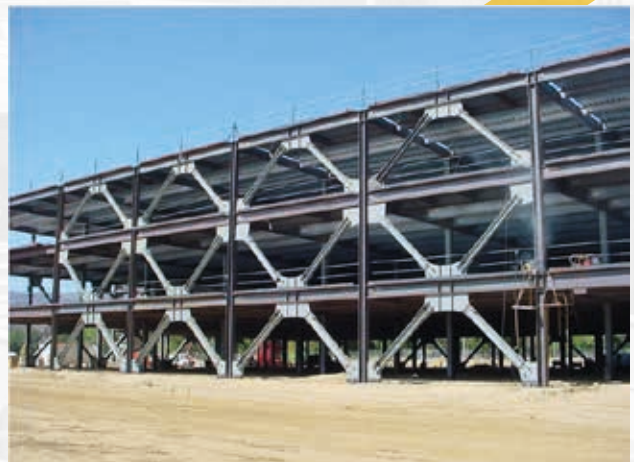
Figura 3. Elementos diagonales en estructuras de acero. (blog.laminasyaceros.com, 2020)
