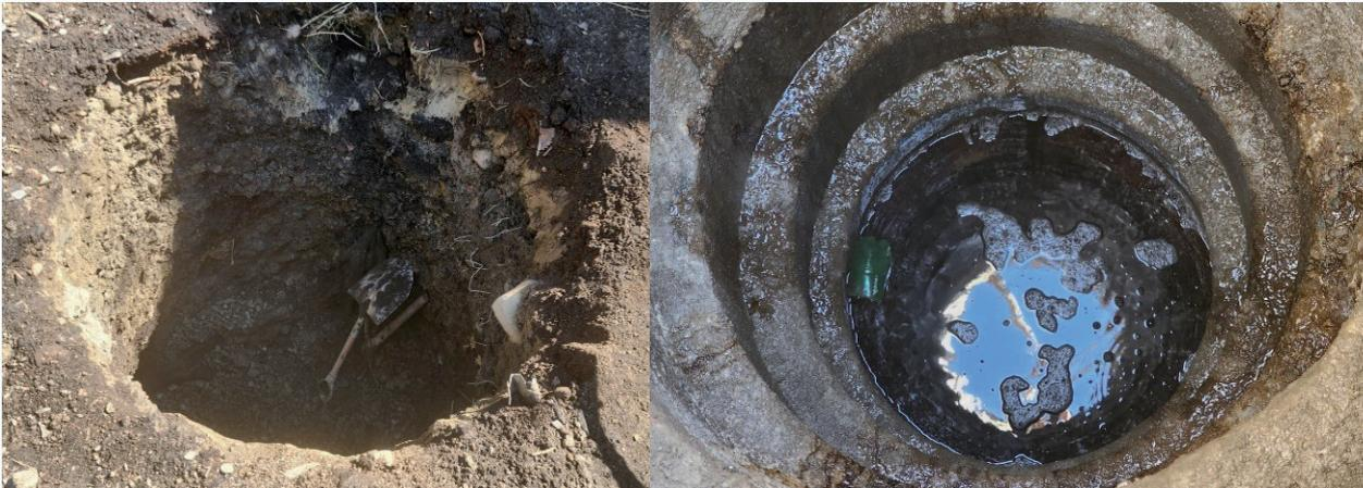
**Figura N° 4.** Presencia de material orgánico y agua residual durante la excavación de un pozo
