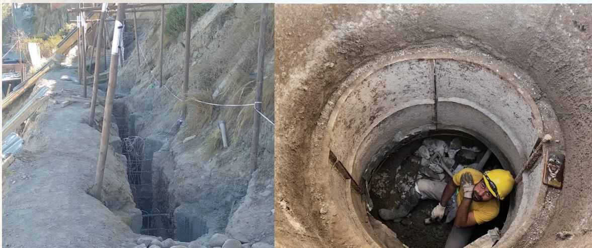
**Figura N° 2.** Proceso de excavación del pozo austríaco
