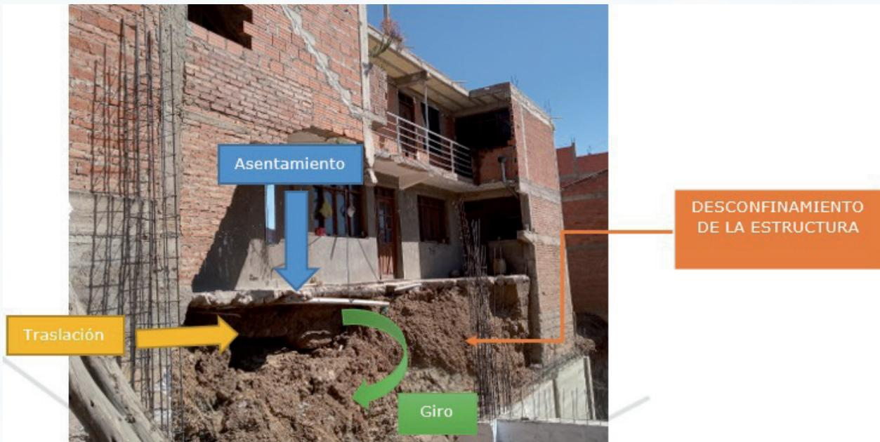
**Figura 4.** Desconfinamiento, ocasionando diferentes esfuerzos
