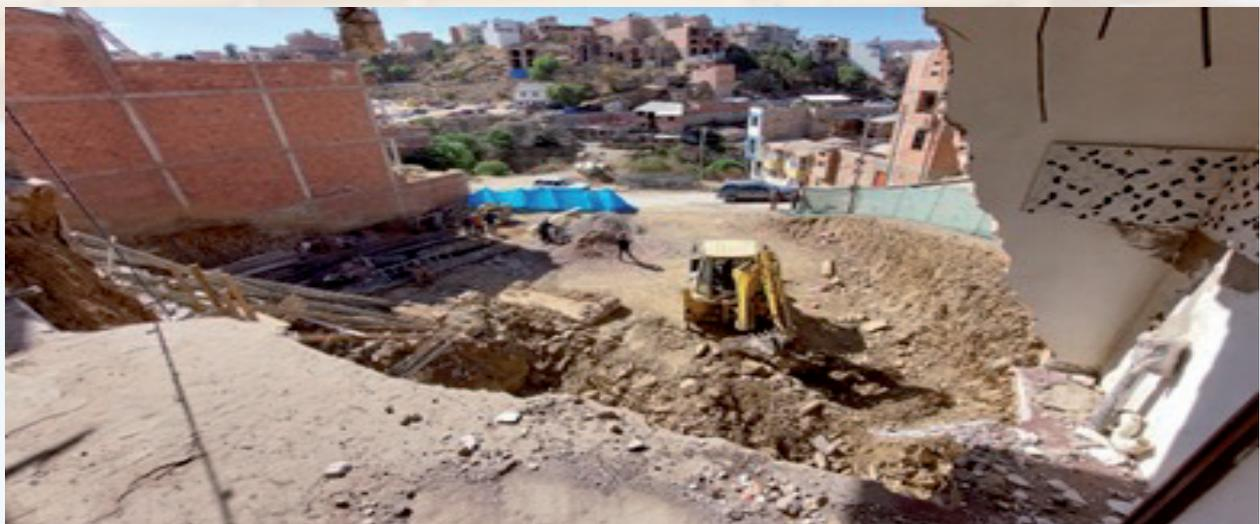
**Figura 3:** Colapso de la estructura mientras trabaja el equipo pesado
