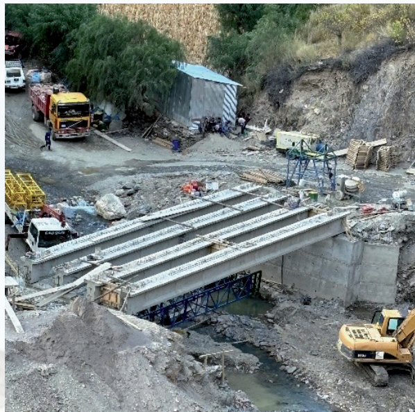
lizado de vigas - vigas emplazadas sobre estribos
