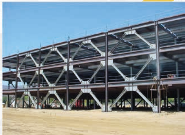
Figura 3. Elementos diagonales en estructuras de acero. (blog.laminasyaceros.com, 2020)
