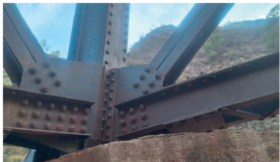
Figura 5. Unión de columna y vigas
