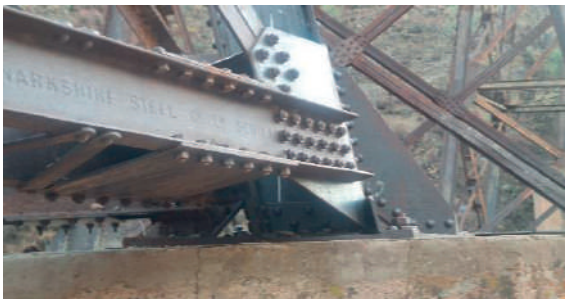
Figura 4. Unión de anclaje
