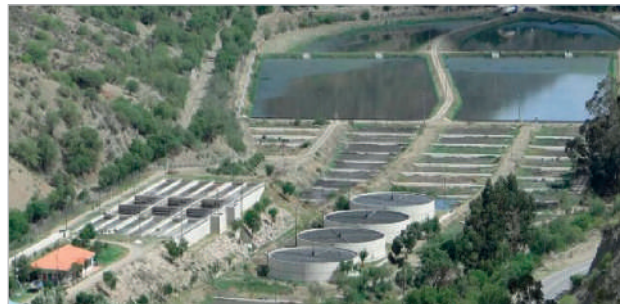
Figura 1 PTAR de Sucre
