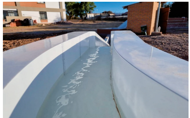
Figura 10 Cintas métricas instaladas para medición de tirantes
