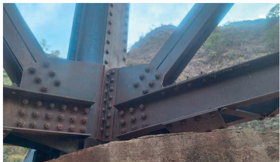
Figura 5. Unión de columna y vigas
