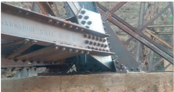
Figura 4. Unión de anclaje
