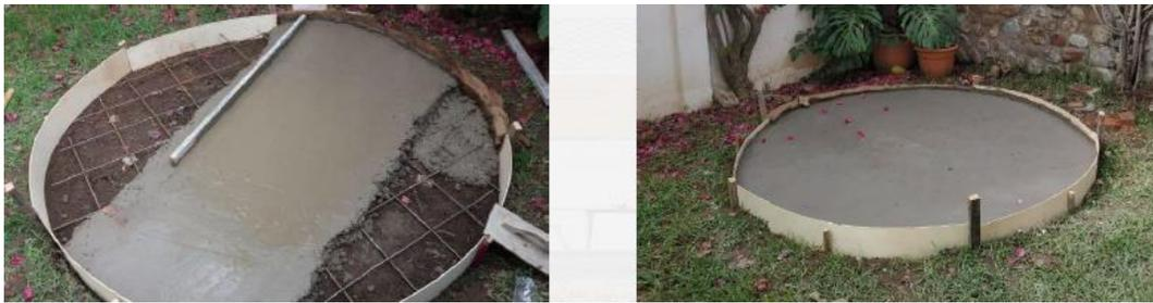
Figura 4. Plataforma de hormigón para el área de contemplación y relajación.
