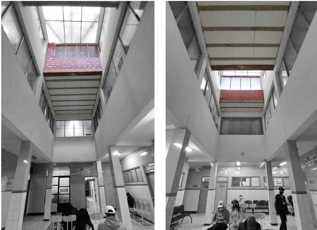
Figura 3. Adaptación de espacios por encima de la sala de espera
