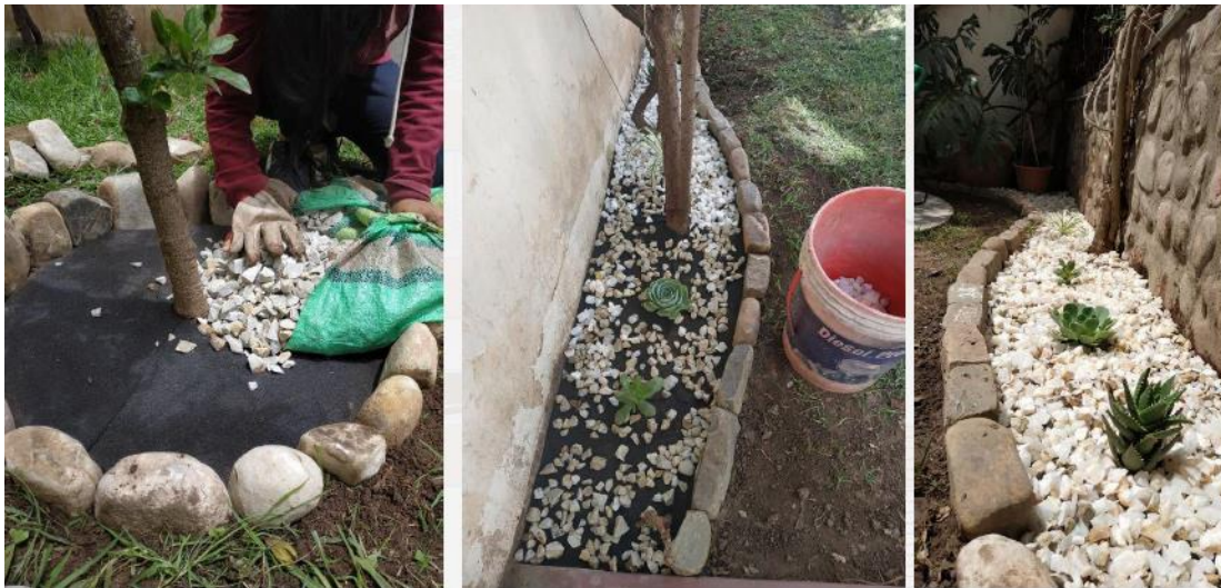
Figura 5. Proceso de ejecución de las jardineras xerófilas, con piedra cuarzo mezclado con mármol picado encima de una base de membrana semisombra. Se utilizaron especies de bajo consumo de agua como la rosa verde y una variedad de suculentas.
